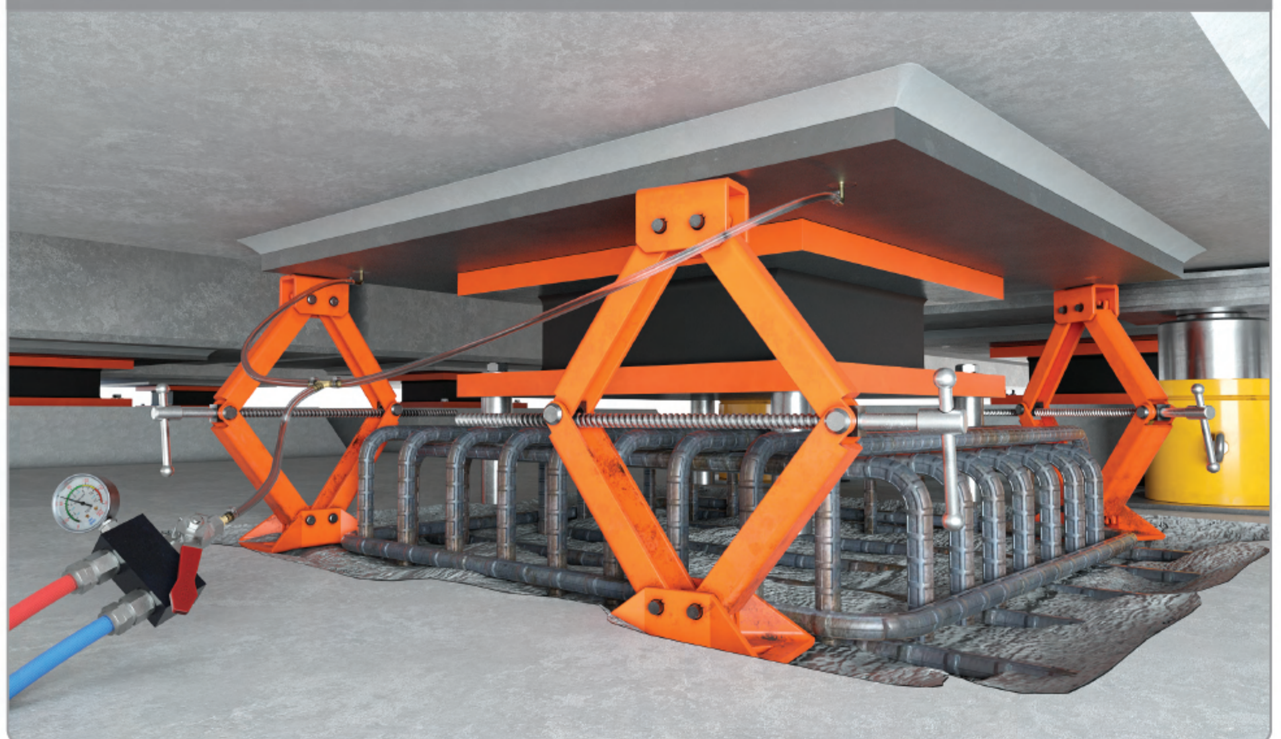
6. 유입 니플에 에폭시 주입관 설치 에폭시 주입
