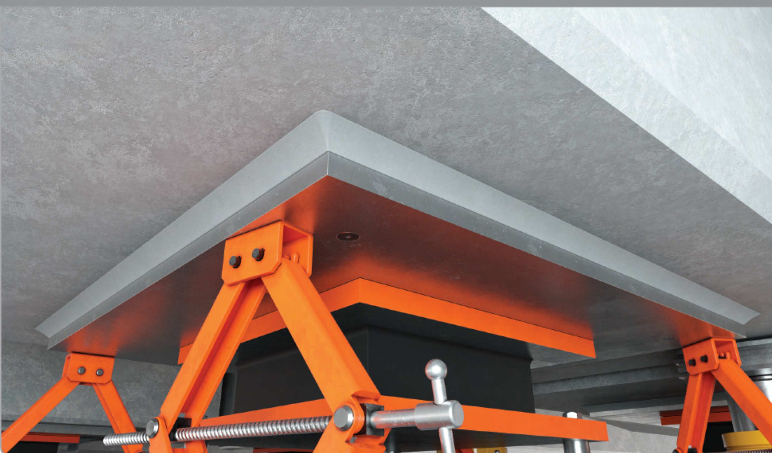
5. 퍼티 작업 댐 설치 밀봉작업
