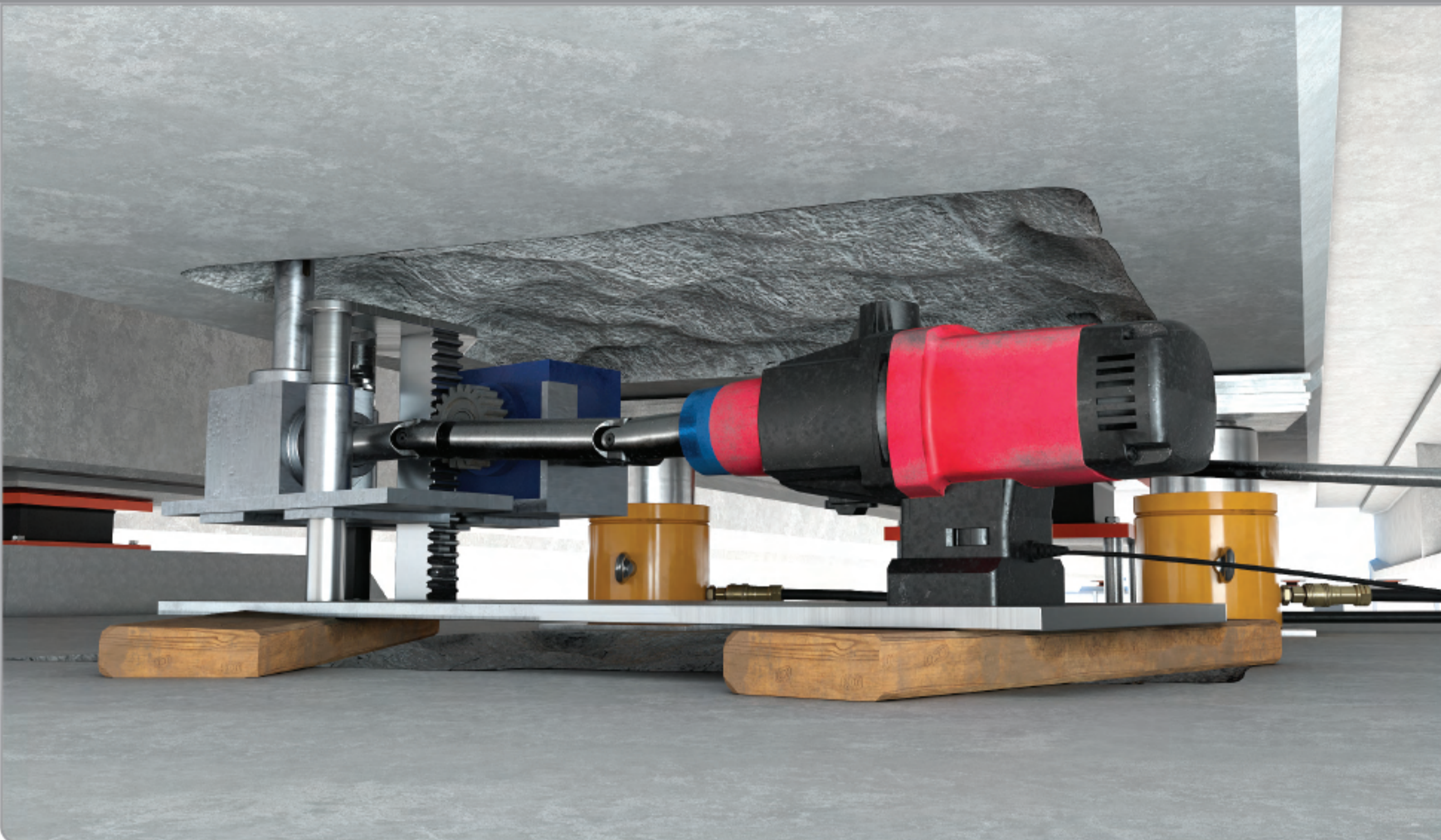
1. 교량받침 상부 콘크리트면 천공 홀 작업
